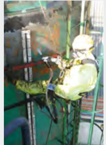
Photo : Hydrogommage de cuve acier.
