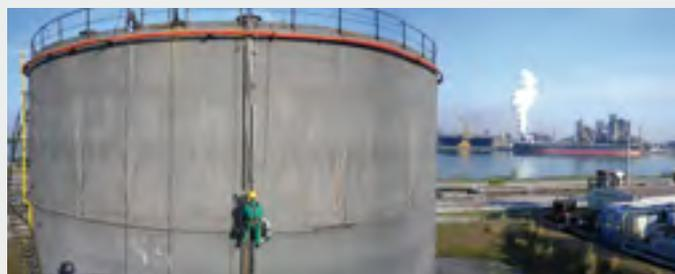
Photo : Pose de gaines spiralées inox sur bac de pétrole
