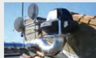
Photo : Pose d'un circuit de gaines spiralées et d'un moteur pour l'extraction de l'air d'une cuisine de restaurant
