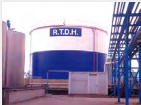
Photo : A la suite d'un traitement anticorrosion sur bac de pétrole, mise en peinture du logo et de l'identification du bac.
