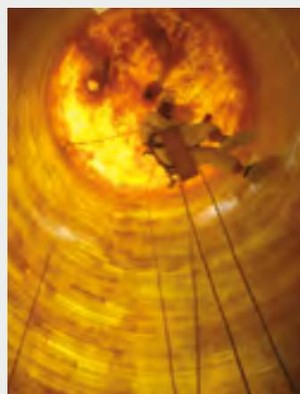
Photo : Nettoyage d'un silo à farine
