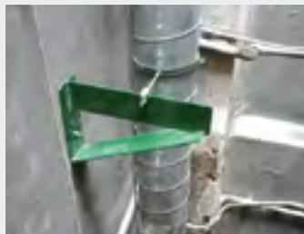
Photo : Renforcement d'un circuit de gaines spiralées par pose de renforts métalliques
