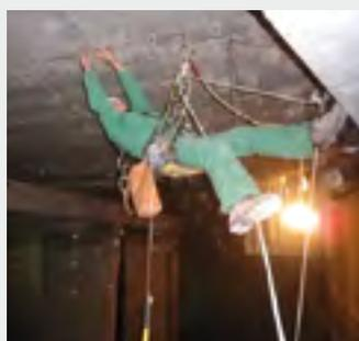
Photos : Pose de radars détecteurs de niveau d'eau dans un bassin d'orage
