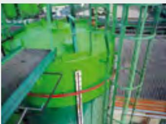
Photo : Renforcement structurel extérieur de cuves acier par stratification à base de résine et de mate de verre. Après travaux de renforcement, la zone stratifiée est mise en peinture.
