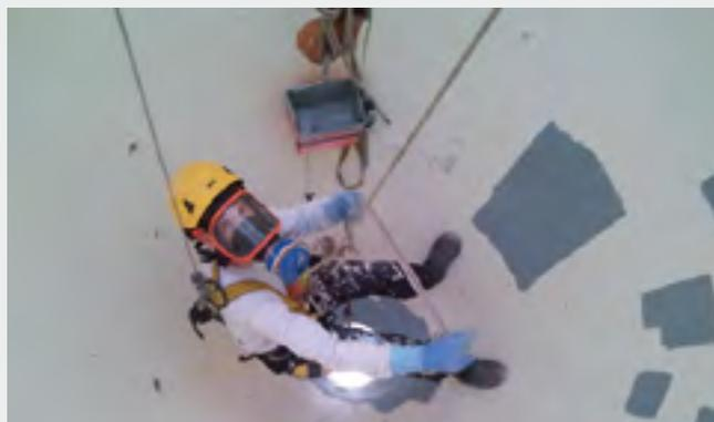
Photo : Traitement intérieur anticorrosion d'une batterie de silos acier.
