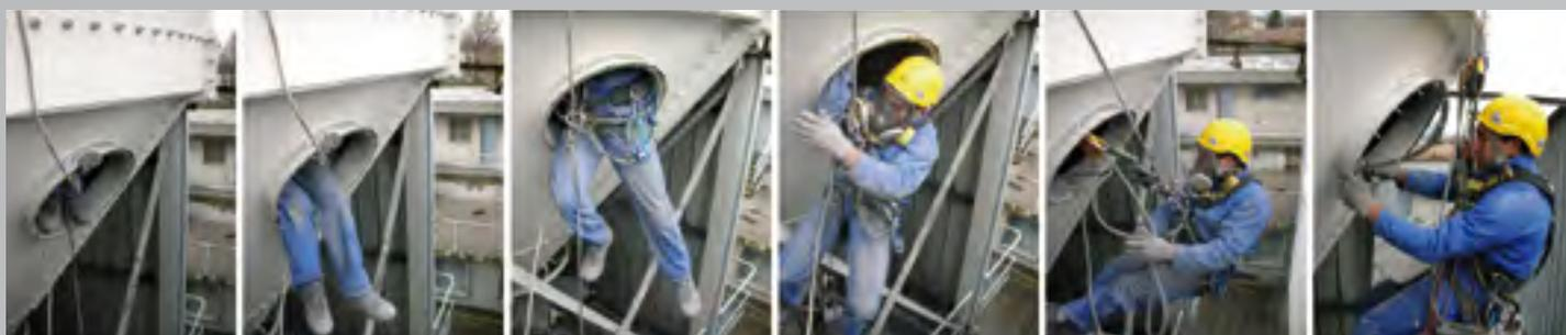
Sortie de silo acrobatique pour remplacement de joint d'étanchéité
